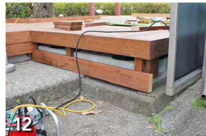
12 幕板を固定。角部分は45度にカットしてつなぎ合わせた(留め継ぎ)
