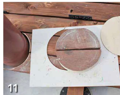
11 ボールがある箇所は、型紙を作り床板をジグソーで切り欠いてから張る
