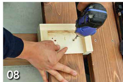
08 床板の固定。ビス位置がそろるように自作のジグを使って下穴をあける
