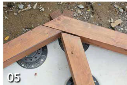
05 調整できたらアジャスターを木材に固定し、ベタ基礎に向かって下穴をあけてからコンクリート用ビスで固定。角部分は基礎に対して現物合わせで角度切りした
