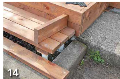
14 ステップを製作。樹脂製の束柱を置き、根太、床板、幕板の順に固定したら完成!
