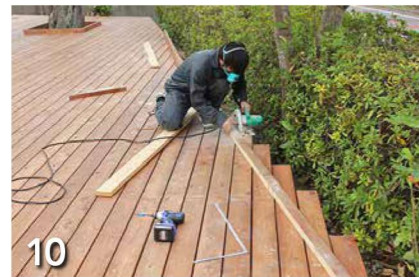
10 床の端部分は長い木材をガイドにして丸ノコで一気に切り落とすと楽ちん
