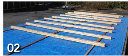
02 (株)ジャンボにヒノキの国産材を発注。事前に塗装するために養生シートの上を広げる
