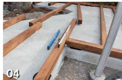
04 根太を配置。基礎と根太の間にアジャスターを挟み、水平になるように調整
