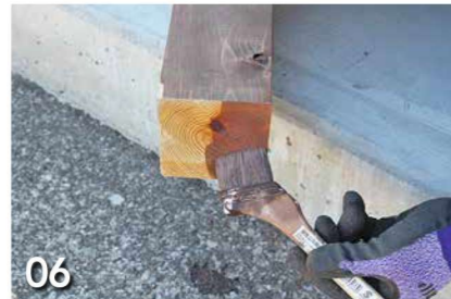
06 カットした木材の木口部分も忘れずに塗装しておく
