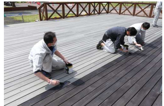
3年目のウッドデッキ 塗料をグングン吸い込みます
