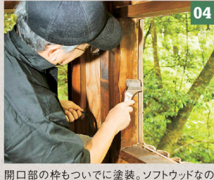
開口部の枠もついでに塗装。ソフトウッドなので、しっかり浸透していく
