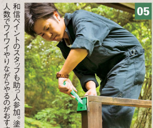
開口部の枠もついでに塗装。ソフトウッドなので、しっかり浸透していく
